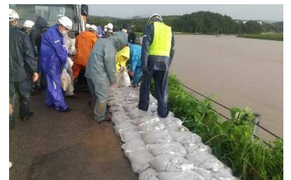
◆豪雨災害対応(土嚢設置)
