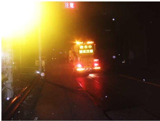
国道8号 加賀市熊坂町地先
