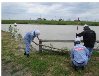
昨年の点検状況 (梯川)
