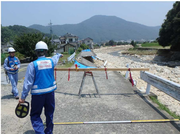
現地調査時の様子 [広島県呉市]
