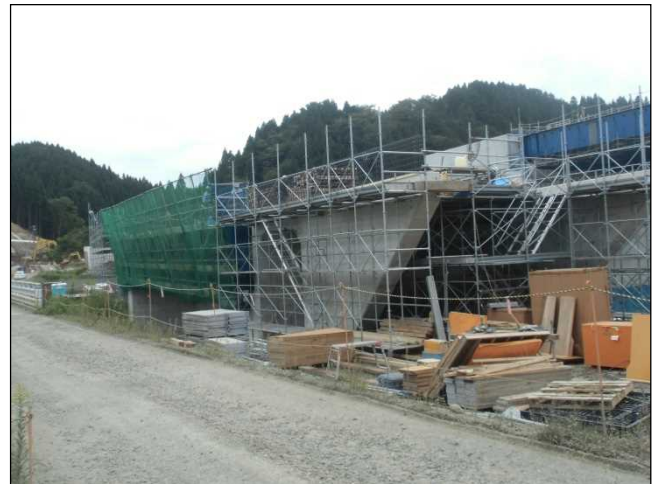
三井IC橋Cランプ上部工事
