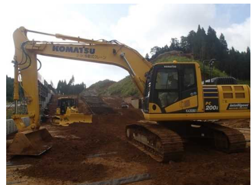
小泉道路その5工事の施工状況
