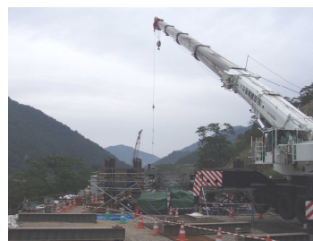
豆谷橋梁 施工状況 (H27.9.24 撮影)
