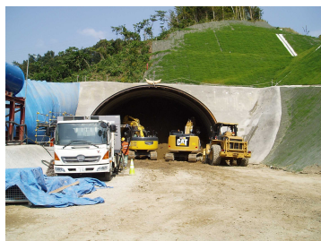
神谷内トンネル 施工状況 (H27.10.9 撮影)
