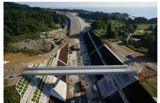
氷見市脇地区の施工状況(10月上旬)
