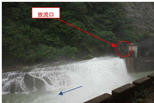
手取川第一発電所取水設備 (ここから取水した水は発電後、河川に放流)
