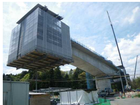
城山高架橋上部その1工事の状況
