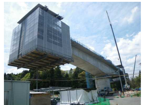
城山高架橋上部その1工事の状況
