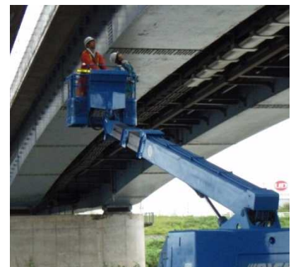
高所作業車を用いた点検
