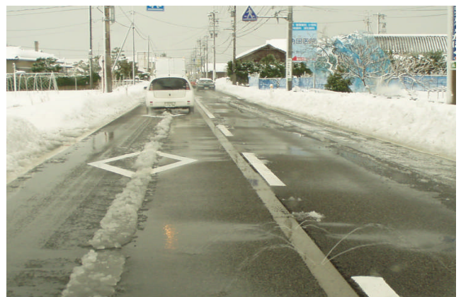
国道159号(かほく市内家屋連担部)消雪パイプ稼働状況
