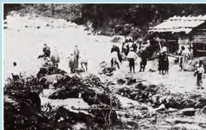
昭和9年手取川大水 災害時の白峰村風嵐 の様子
