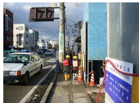
現況写真(金沢市橋場町)
