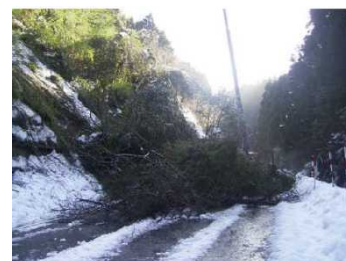
写真②：法面からの土砂崩壊 (国道160号七尾市庵町地先)
