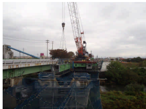
桁架設状況（加賀大橋）
