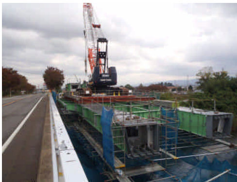
桁架設状況（加賀大橋）
