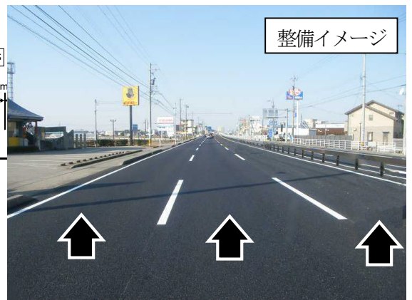
整備後 (金沢側より小松方向を望む)
