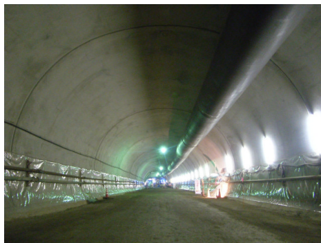
工事中の卯辰トンネル坑内の状況 (写真は東長江側坑口から約400m地点、 残る主な工事は舗装・照明・防災設備等)
