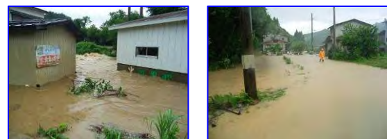
H16.7出水被害状況（宮の台地区）
