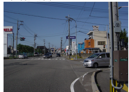
稲荷交差点の現況 (金沢側より白山側を望む)
