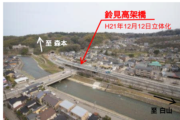
立体化後の鈴見交差点全景
