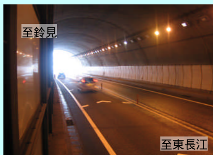
卯辰トンネルから鈴見方面を望む
