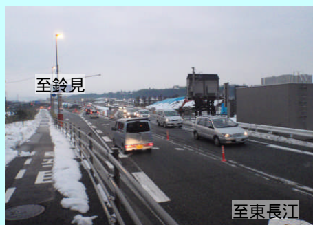
卯辰トンネルから鈴見方面を望む
