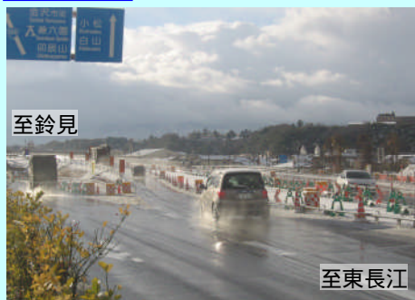
卯辰トンネルから鈴見方面を望む
