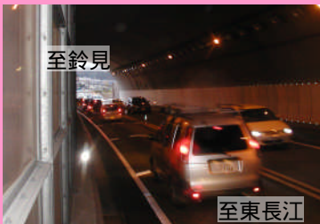
卯辰トンネルから鈴見方面を望む
