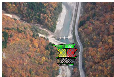
河内谷砂防堰堤 (S18.10月完成)
