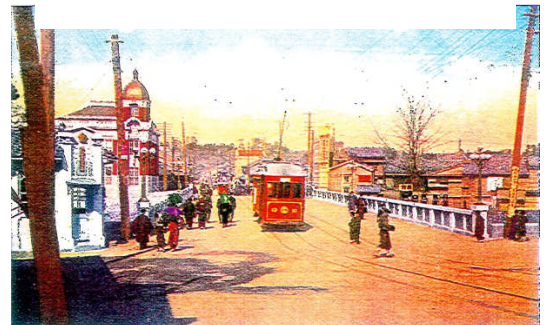
鉄筋コンクリート橋（市電の通る橋）
