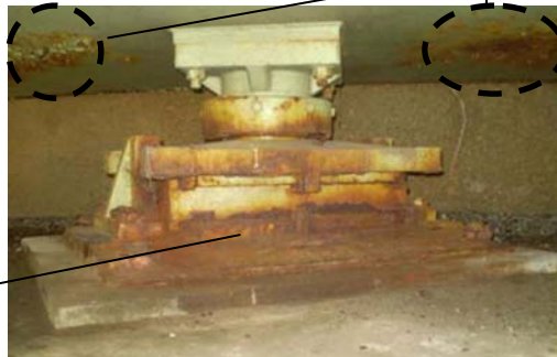
塗装の劣化及び支承の腐食状況
