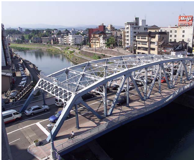
【犀川大橋全景】
