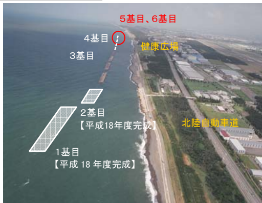
小松工区の状況 【小松市浜佐美・日末地先】(平成17年8月撮影)
