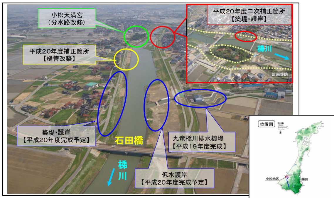
改修の進む梯川（平成20年4月撮影）
