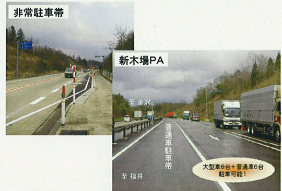
新木場PA・非常駐車帯の設置(平成17年度)
