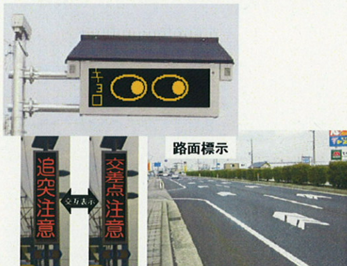
速度検知型追突防止情報板の設置(目玉キョロ) (平成18年度)
