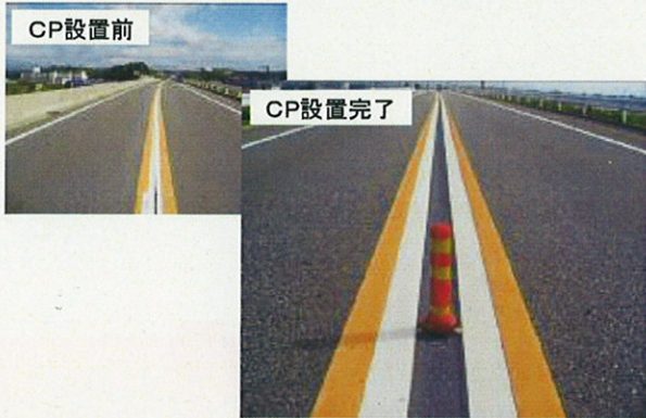
センターポール(CP)の設置(平成16年度)
