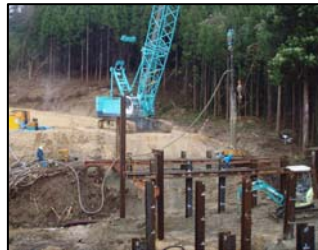
仮橋の杭の 建て込み状況
