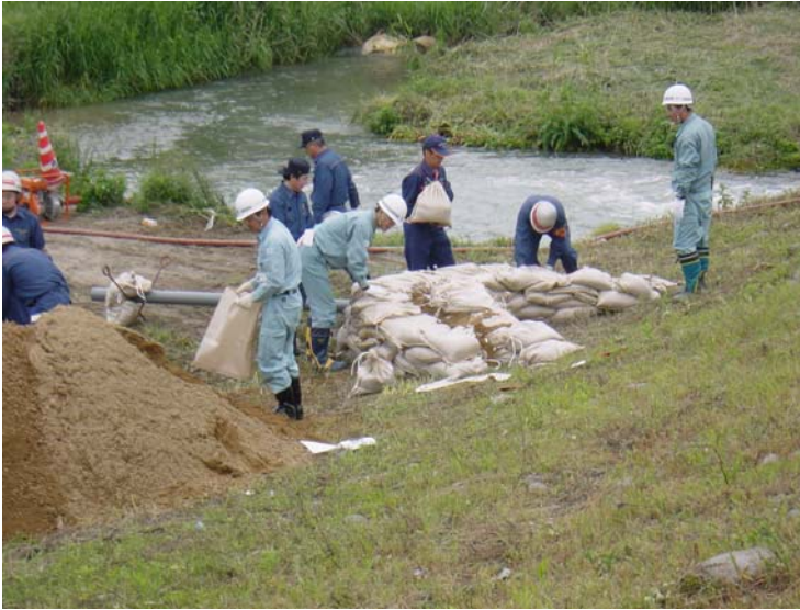
平成18年度の実施状況 「月の輪工」の作業状況
