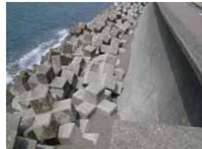
消波工の沈下状況
