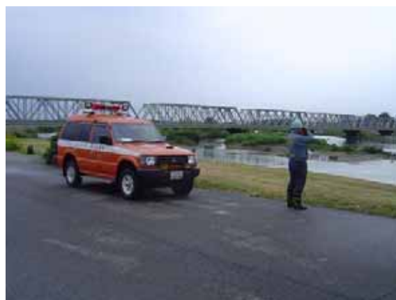
図 80 河川巡視（平常時）の状況
