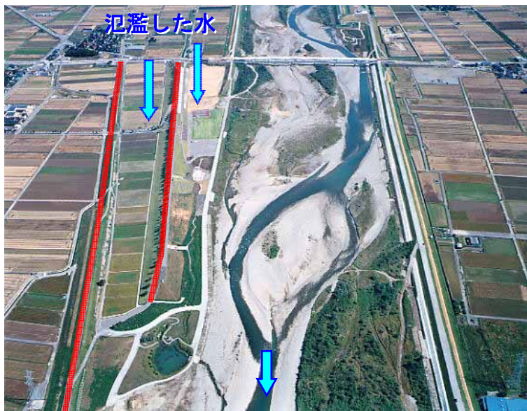
図 77 手取川 とくろうじま の霞堤 (川北町与九郎島地先 右岸 6.6k 付近)
