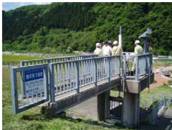
図 78 河川管理施設の点検
