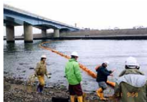
図 76 河口部オイルフェンス設置状況 (ロシアタンカー重油流出事故 平成 9 年 1 月)
