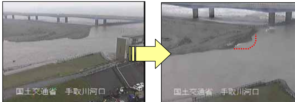
図 81 CCTV画像による観測（調査の一例）
