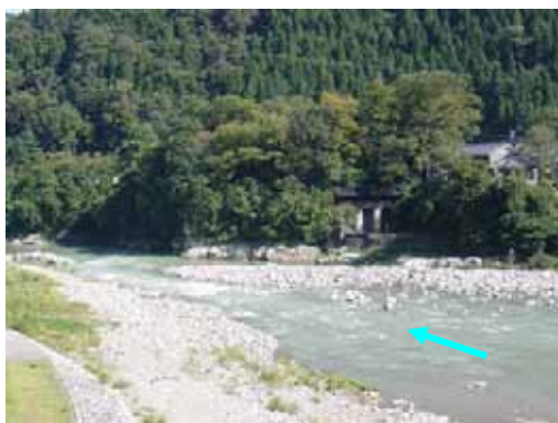
図 16 七ヶ用水大水門と安久瀧ヶ淵
