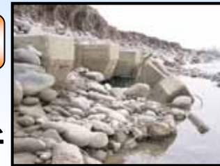
H16.10.20台風23号出水での侵食状況
