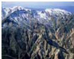
上流の崩壊地
