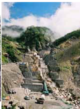
導流落差工の施工状況
