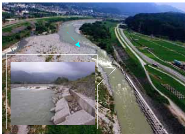
手取川被災箇所（根固工流出） 石川県能美市 とだしの 灯台笹地先
