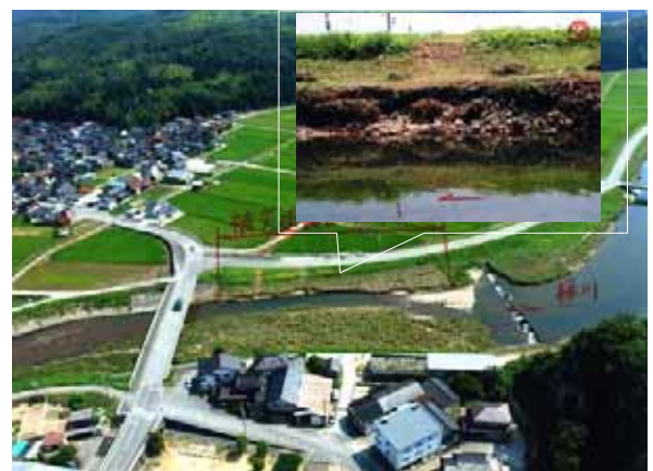
梯川被災箇所（護岸欠損） 石川県小松市 なかうみまち 中海町地先
