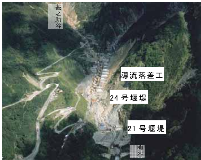
柳谷上流砂防堰堤群の全景
