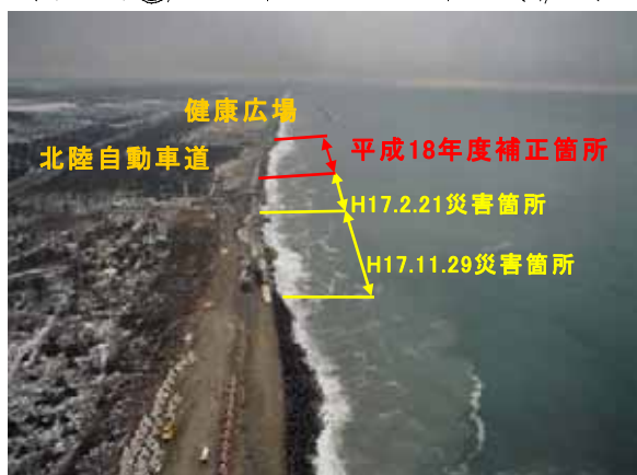
平成18年度補正予算 施工箇所 【小松市日末地先】（平成18年1月撮影）
