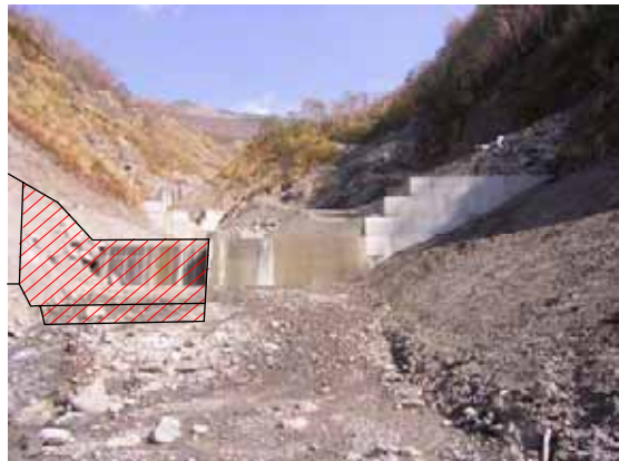
別当谷第15号えん堤（平成18年10月撮影）
