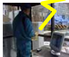
リモコン操作による無人化施工の状況
