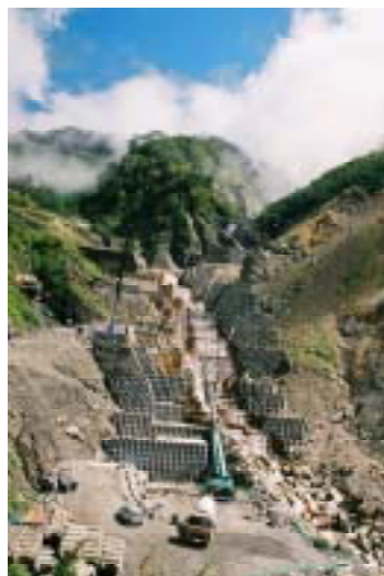
導流落差工の施工状況
