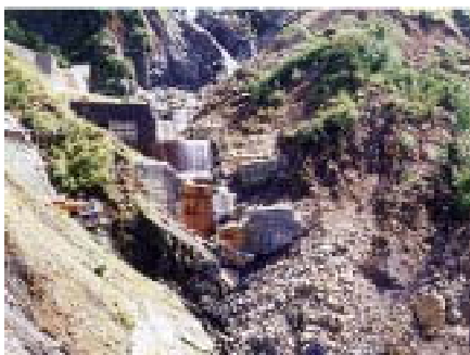
H4年の出水による柳谷第3号、第6号砂防堰堤の被災状況
