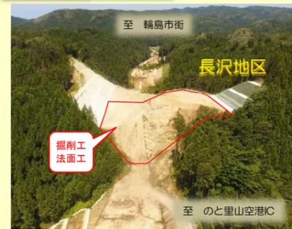
本工事は、前年度工事に引き続き、三井町長沢地区において、掘削工、法面工を主に施工いたします。また、平成28年度より掘削を開始した長沢切土工区も、今回の工事で計画道路高さまで掘削する予定です。
