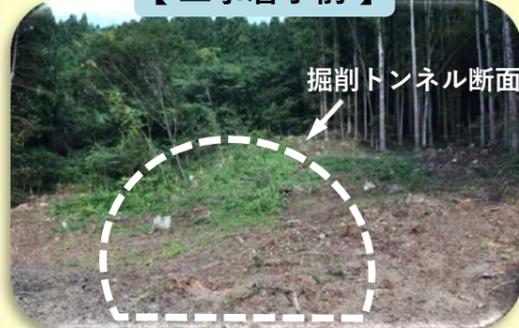
トンネルの掘削断面は、高さ約9m、幅約15mと2車線のトンネルとしては大断面となります。
