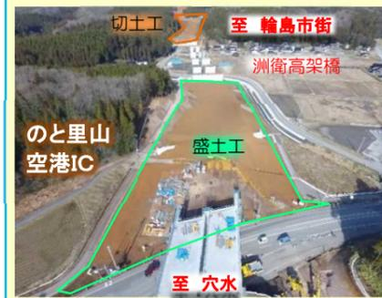
本工事は、三井町洲衛地区にて主に本線の掘削・盛土、擁壁工を施工するものです。本工事では現場の安全・生産性向上を図るため、ICT(情報通信技術)対応建設機械を用いて施工します。土砂の運搬について、工事中は市道市ノ坂洲衛線および県道柏木六水線より工事車両の頻繁な出入りが予想されます。皆様にはご迷惑をお掛けしますが、安全第一・一般車両優先をモットーに工事を進めさせていただきますので、ご理解・ご協力の程よろしくお願いいたします。
