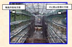
本工事は、三井町洲衛地先において、造林 作業路牛ヶ谷線にボックスカルバートを構築し ています。
