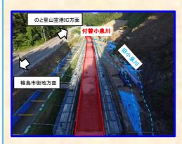
本工事は、三井町小泉地先において、 小泉川の付替え工事をしています。 現在、水路底版部の鉄筋と型枠組立の 施工中です。
