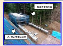
日頃より工事にご理解を頂き、ありがとうございます。 本工事は、その1工事より約180m輪島市街地よりで、ボックスカルバートを構築しております。
