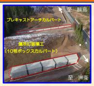
本工事は、昨年3月より輪島市三井町小泉地区において、輪島道路本線にかかる作業道小谷内線の通行を確保するための現場打ち函渠及び横断水路を確保するためのプレキャストボックスを施工し、昨年12月に完成しました。工事期間中は、作業道の通行制限に対し、深いご理解を頂き、地元の皆様には大変感謝いたしております。おかげさまで無事故無災害で完成を迎えることが出来ました。完成した函渠内は通行可能でありますが、今後も事業が続きますので通行の際はご注意ください。
