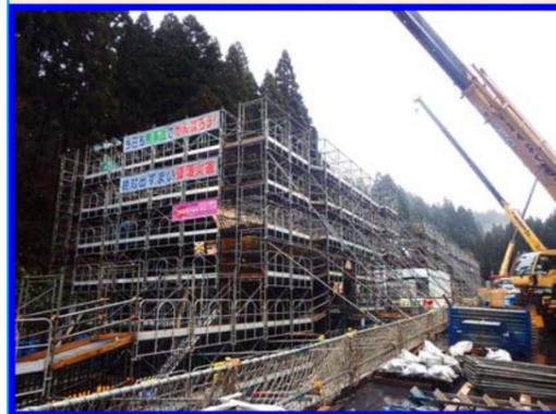
本工事は三井町長沢地内において、盛土の中を横断するアーチ型のボックスカルバートを施工しています。写真は底版コンクリートの打設が完了し、手前では壁部を、奥ではアーチ部の施工を行っているところです。今後とも皆様方のご理解・ご協力をお願いいたします。
