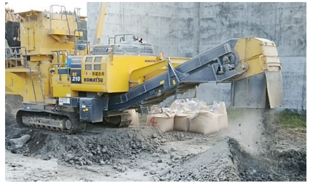
【悪い土を盛土材に使用するためセメント量を増加】
