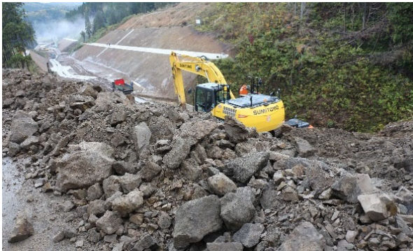
【掘削中、1mを超える岩塊が発現】
