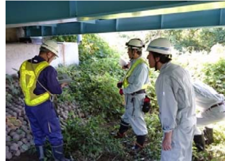
【橋梁実地点検研修(実習)】
