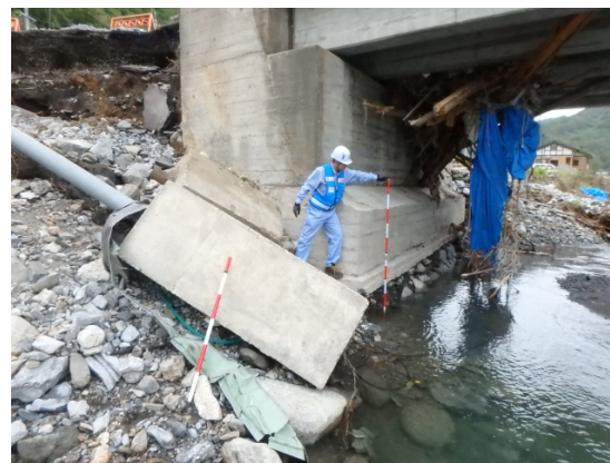
【橋梁点検調査】
