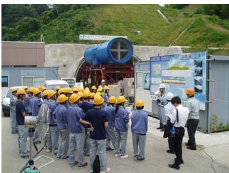
【工事概要の説明を受けている様子】
