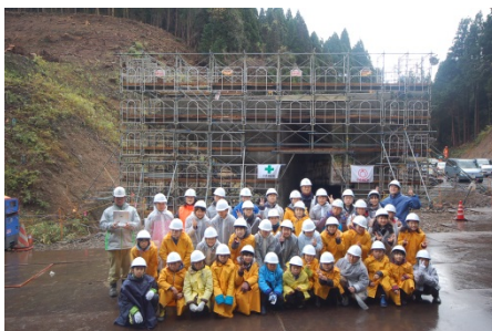
【工事現場での集合写真】
