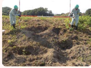
イノシシにより掘り起こされた堤防
